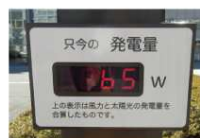
▲発電量表示パネル
