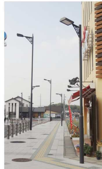
■車道用照明器具：HS-2048 型 ・光源 : LED ・器具高 : 10.0m
