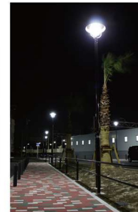
■歩道用照明器具：HS-525 型 ・光源 : LED (白色) ・器具高 : 4.5m
